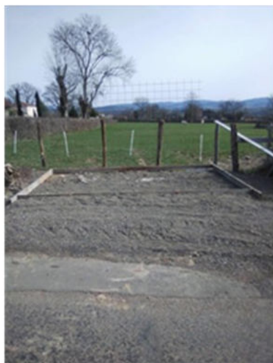
Réalisation de la dalle en béton.
