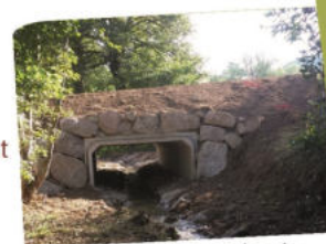
Pont cadre installé sur le Chandonnet
