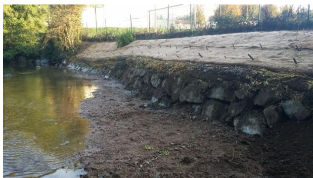
Fin de chantier
