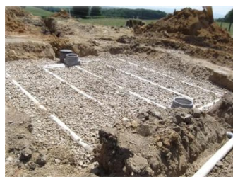
Filtre à sable vertical drainé
