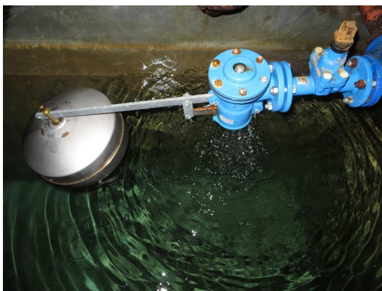
Suppression de Mussy Vauban
