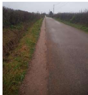
Rechargement des accotements route de la Chenauderie
